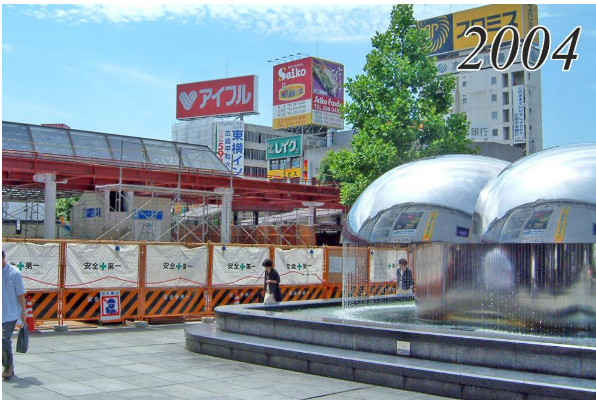
路面電車ホームと駅ビルを結ぶ屋根が工事だった
